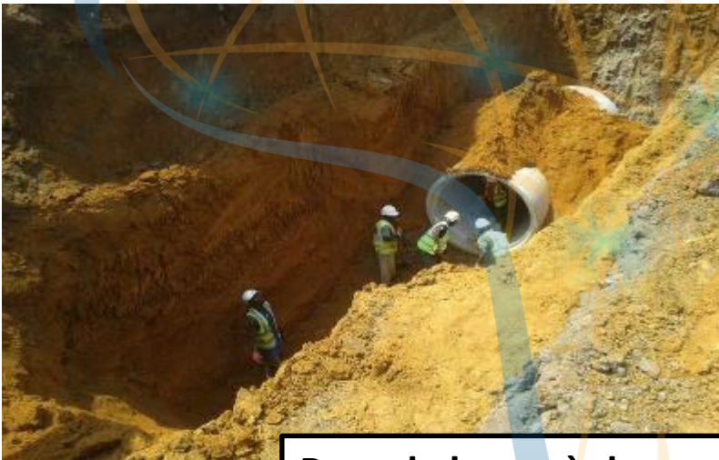
Pose de buses à de grandes profondeurs (8ml)
