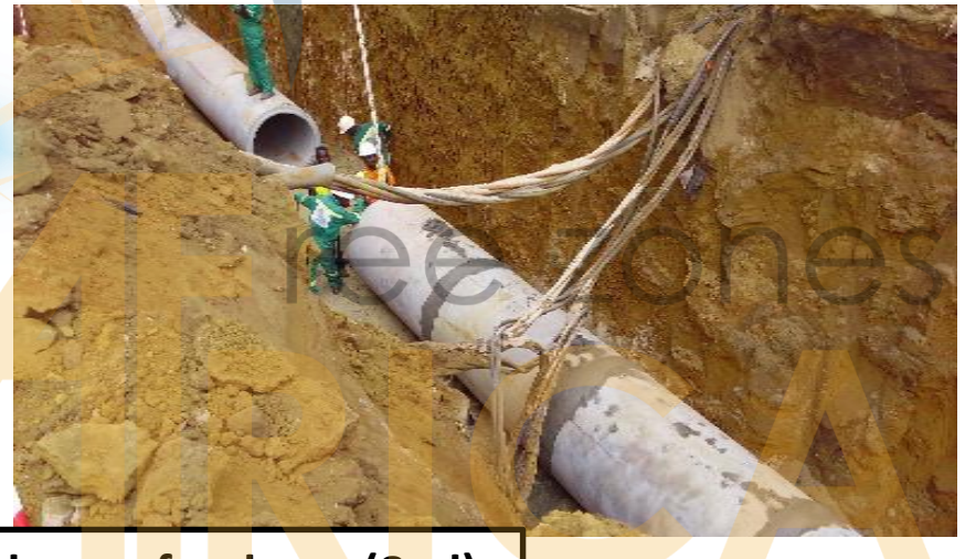
Pose de buses à de grandes profondeurs (8ml)
